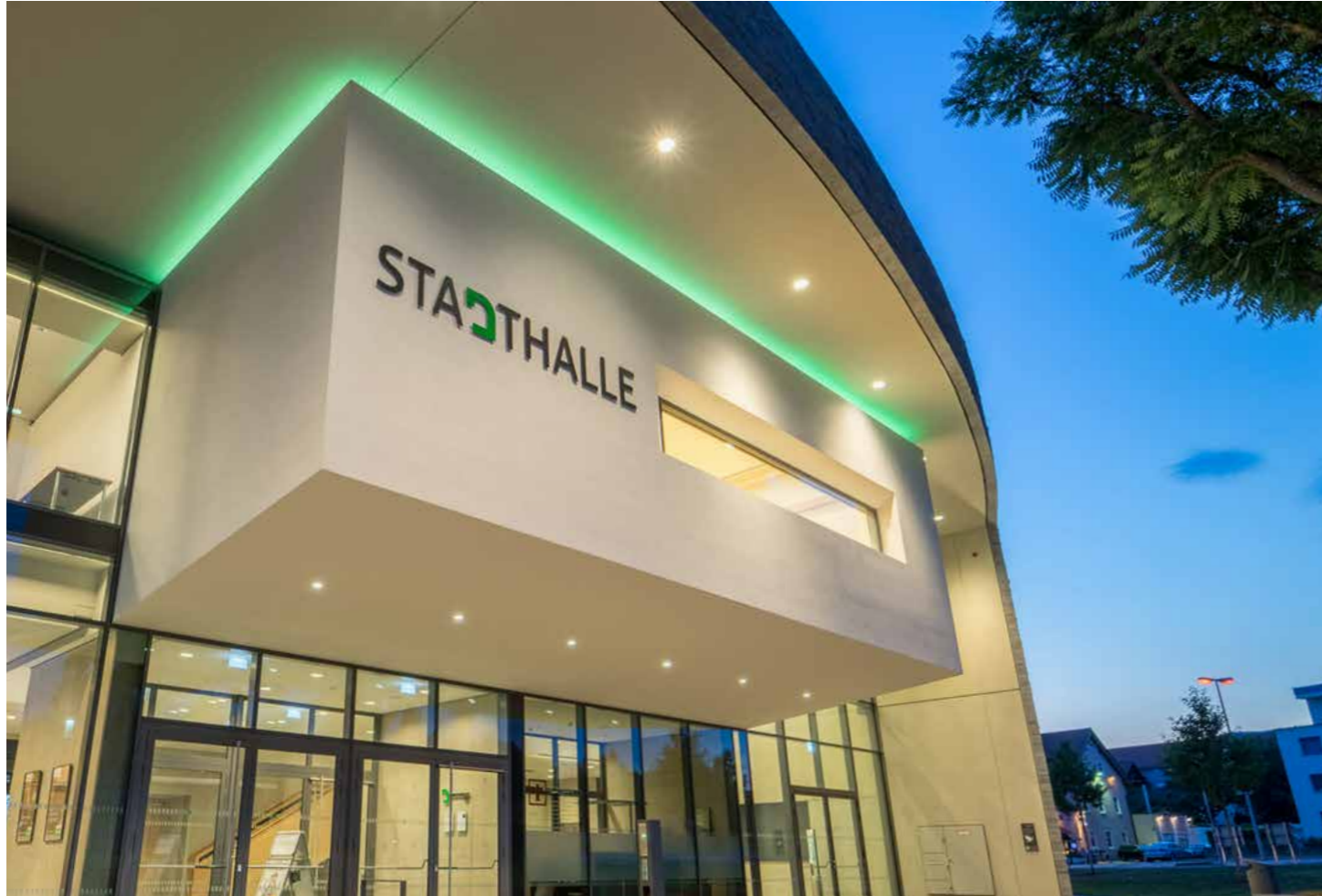
KUNDE: Stadt Bad Neustadt/Salle | LICHTPLANUNG: abi - Technische Gebäudeausrüstung | FOTOGRAF: ©Cristopher Civitillo
